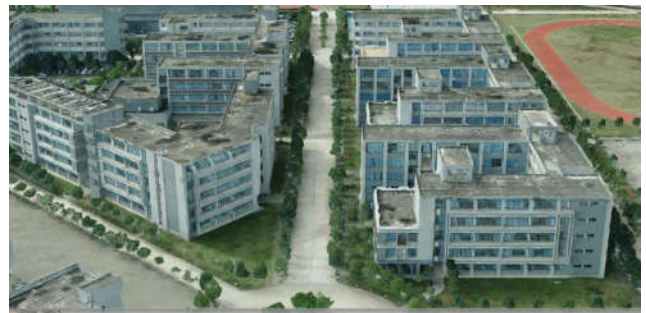
图3 三维模型中出现的漏洞
