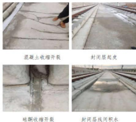
在汲取公路路面结构的优点并结合高速铁路路基结构特点，在潍烟高速铁路建设过程中，采用了沥青混凝土作为封闭层，通过沥青混凝土延展性与封闭性来解决
