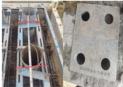
图3 锚栓孔定位工装
