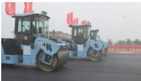
图1 沥青混凝土智能化初压
