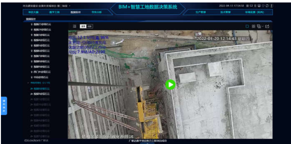
塔吊吊钩可视化实时监控
