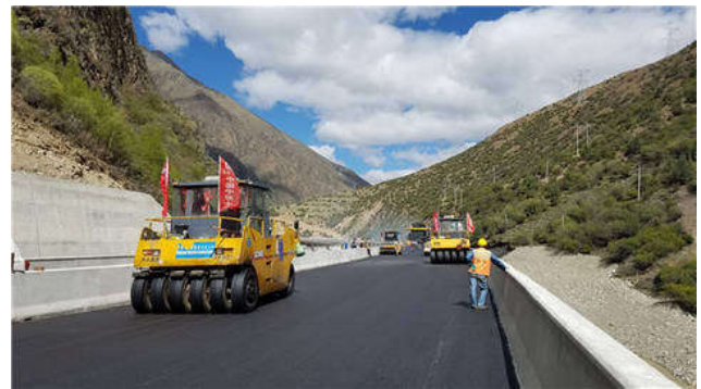
高原地区路面施工如图所示
