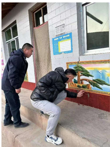
图2 现场勘探房屋安全
