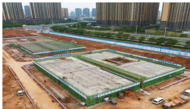
土木工程施工现场如图所示
