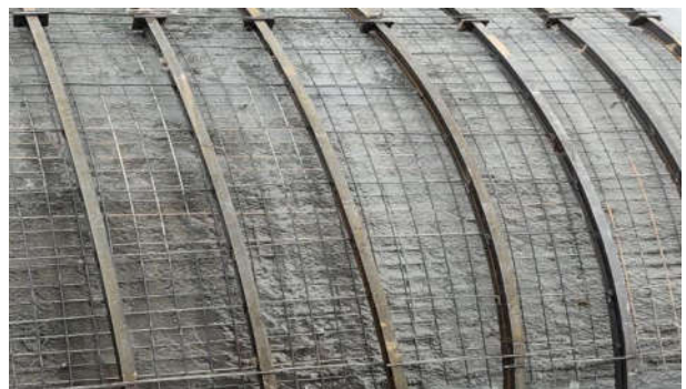
图3 拱盖工字钢安装
