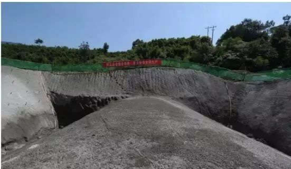
图2 暗洞初支初喷面
