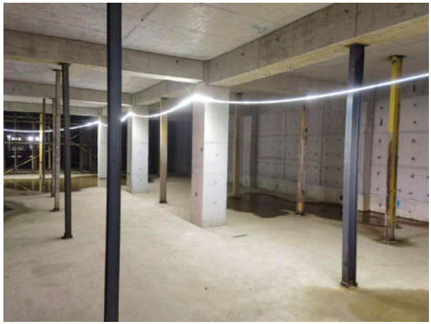
图1 型钢回顶实景图
