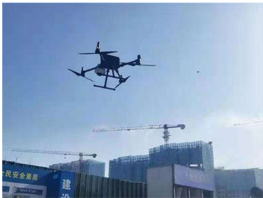
图1 无人机巡视施工现场
