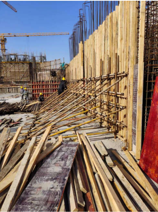
图 1 支撑体系布置实景图
