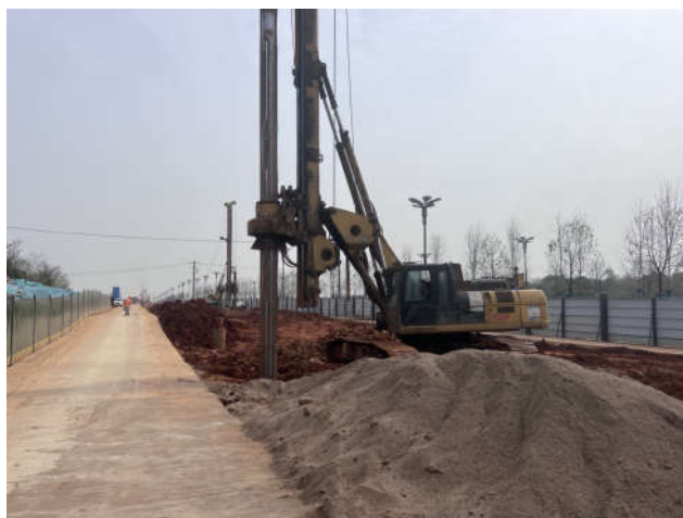
图5 机制砂回填施工图
