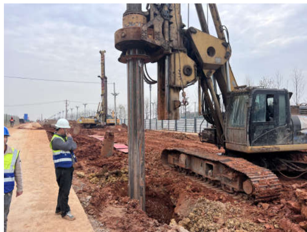
图4 旋挖钻机引孔施工图
