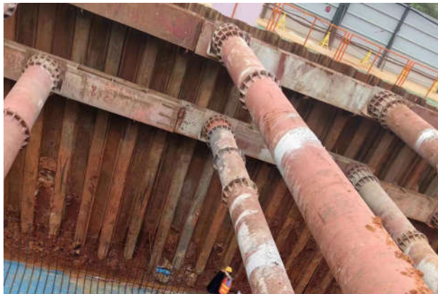
图1 钢板桩现场实施图
