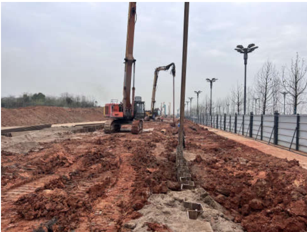
图6 钢板桩插打施工图
