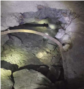
图2 支护结构整体失效
