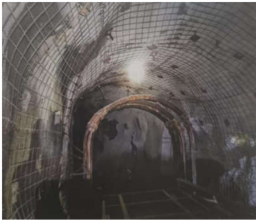
图3 眉线位置锚喷网+锚索+钢拱架支护
