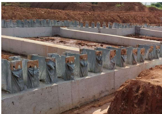
图1 型钢桩现场实施图
