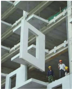
图1 预制外墙施工
