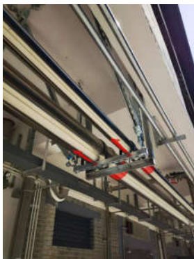
图8 抗震支架施工实景图
