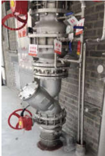
图2 竖向管道雨淋阀组安装实景图
