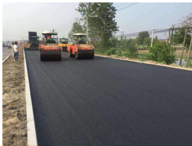
图1 沥青混凝土施工
