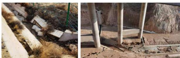
图1 强降雨造成水沟结构破坏、淤塞
