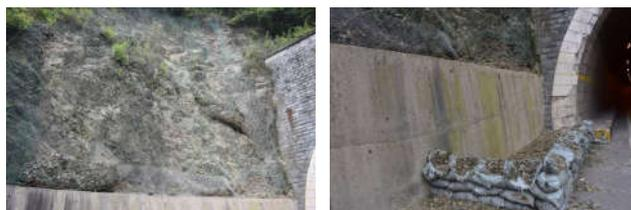
图3 布鲁克网碎石堆积,且局部破损,有碎石掉落
