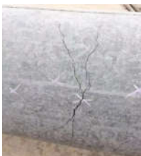
图4 承载力检验弯矩时混凝土电杆破坏情况
