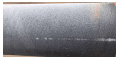
图6 承载力检验弯矩时混复合材料电杆破坏情况
