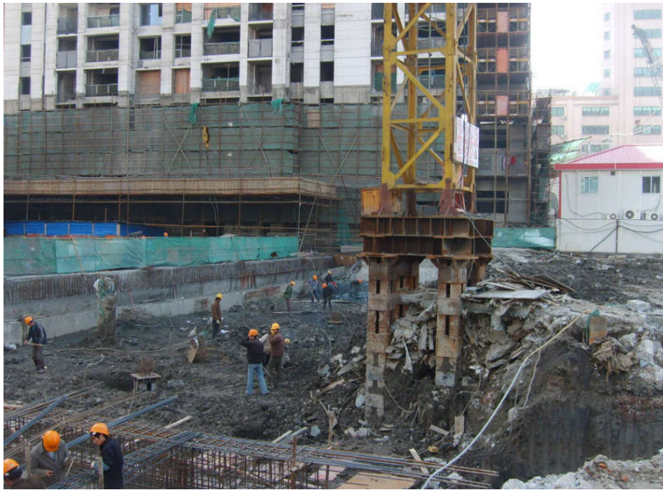
图1 深基坑开挖与支护施工现场
