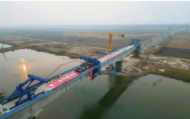
桥梁工程如图所示
