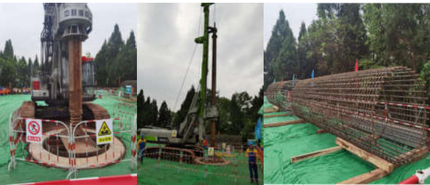
图2 川渝特高压交流工程线路工程钻孔灌注桩现场施工图
