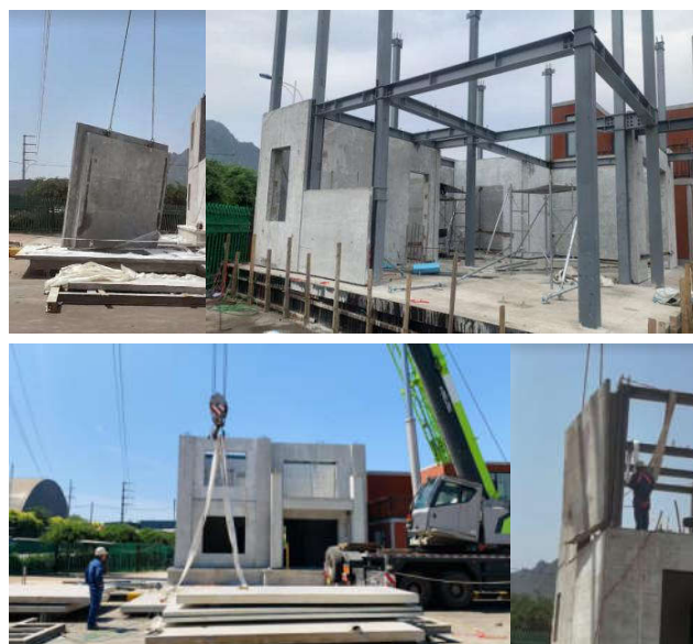
图6 津西自建钢结构二层样板房
