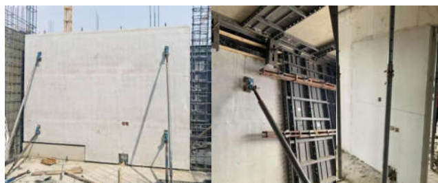
图5 中海项目PFC分户墙现场应用情况
