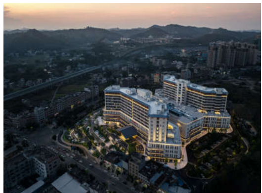
图1 医疗综合楼鸟瞰图（笔者拍摄）
