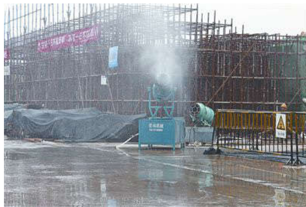
图3 工地喷雾降尘
