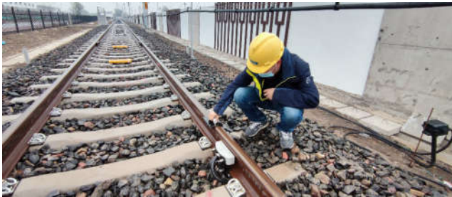
图5-1 天津地铁现场试验
