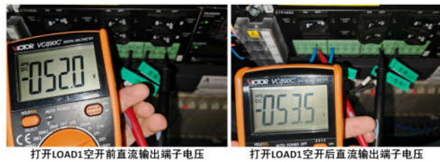
图2 ETP4890 A机LOAD1空开打开前后直流输出端子电压值示意图
