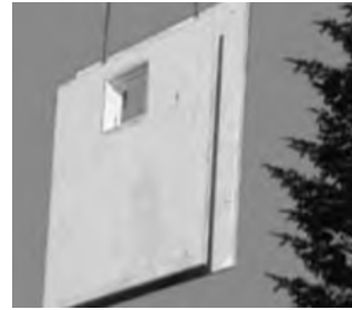
图1 叠合墙板吊装操作
