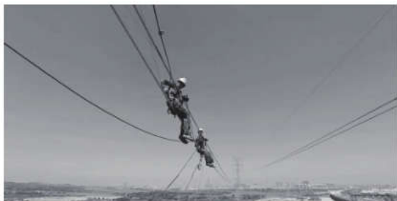
图1 输电线路监测维修
