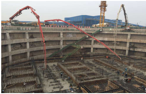
图1 底板混凝土浇注
