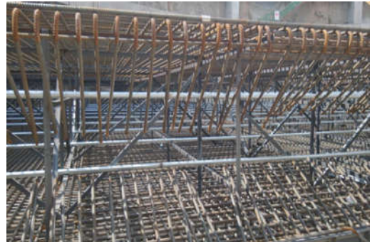
图2 冷却水管布设
