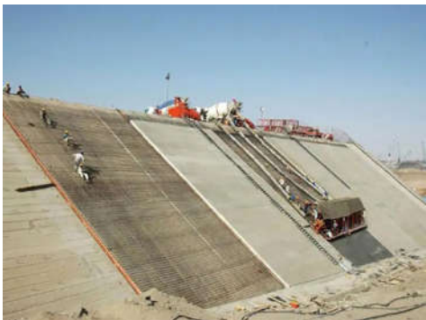
水利水电大坝加固如图所示
