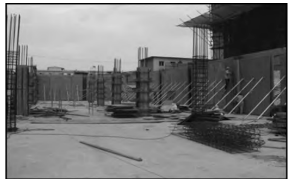
图1 外框架梁柱施工
