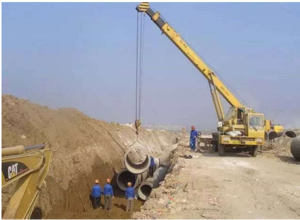
市政给排水管道施工如图一所示
