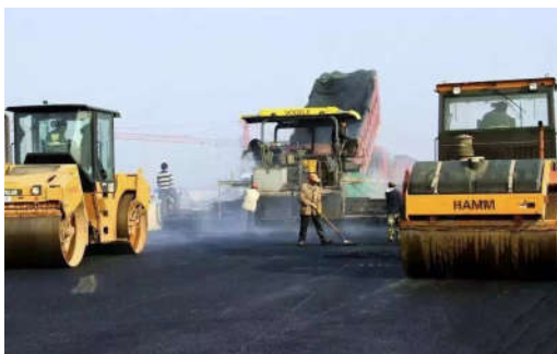
沥青混凝土道路施工技术如图一所示
