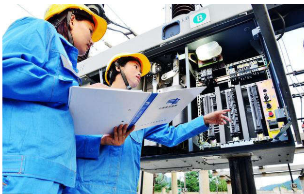
变压器故障处理如图一所示
