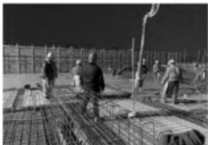
图1 混凝土的浇筑
