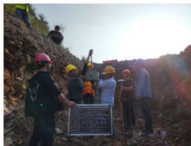
图4 地基承载力检测
