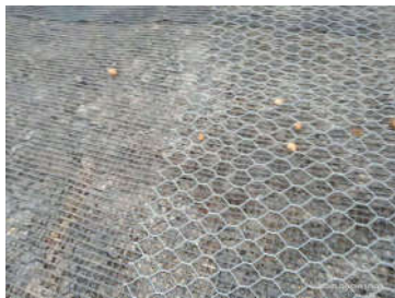
图7 加筋格栅铺设
