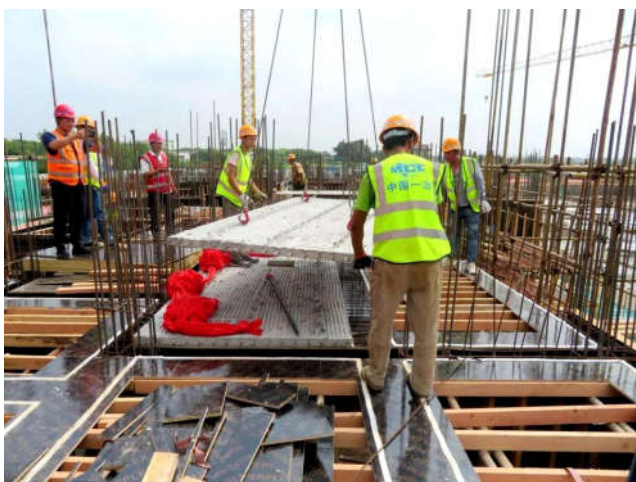
图1 施工过程中的吊装施工技术
