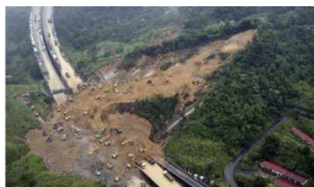
图1 山体滑坡造成公路损坏
