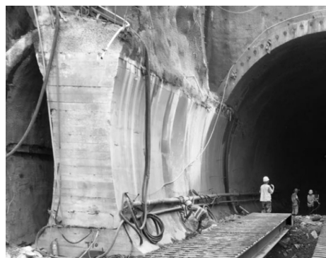
图5 中隔墙拱顶密实度控制效果图
