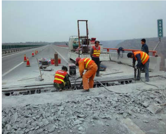
图2 公路桥梁伸缩缝开槽现场
