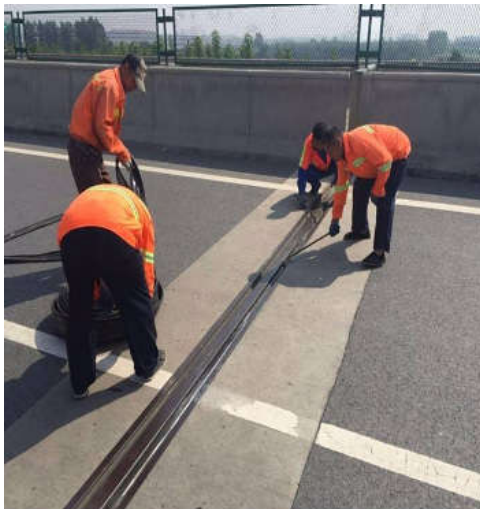
图1 公路桥梁伸缩缝施工现场
