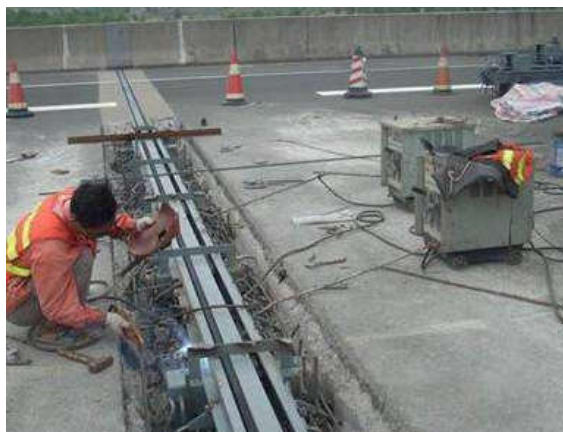
图3 公路桥梁伸缩缝型钢安装现场
