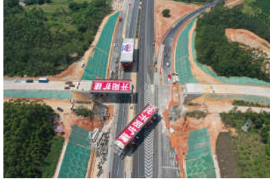
图4 SPMT快速拆建现场
