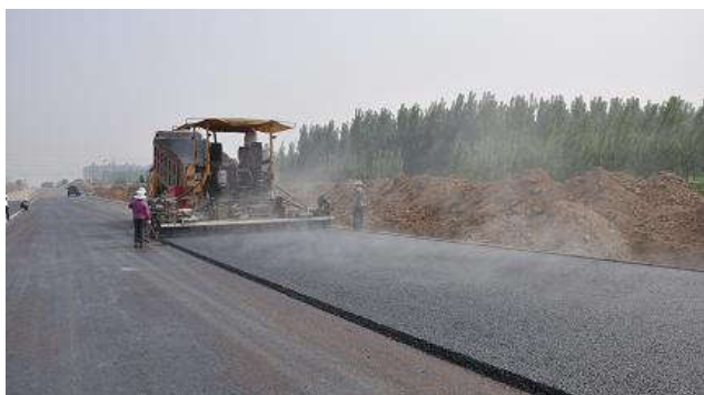
图1 沥青混凝土路面施工
