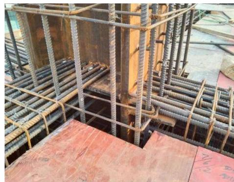
图3 现场穿筋节点
