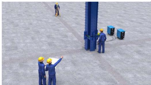
图5 BIM模拟全站仪测量图
