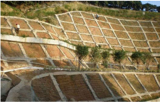
边坡加固技术在岩土工程中的应用
