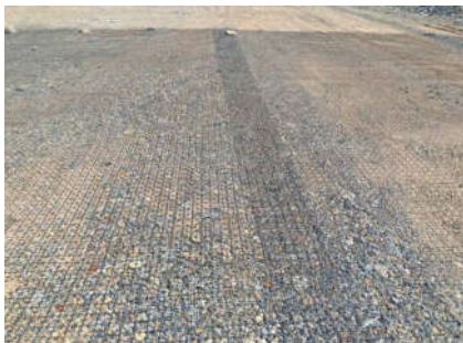
图3-2 多向土工格栅铺设施工图
