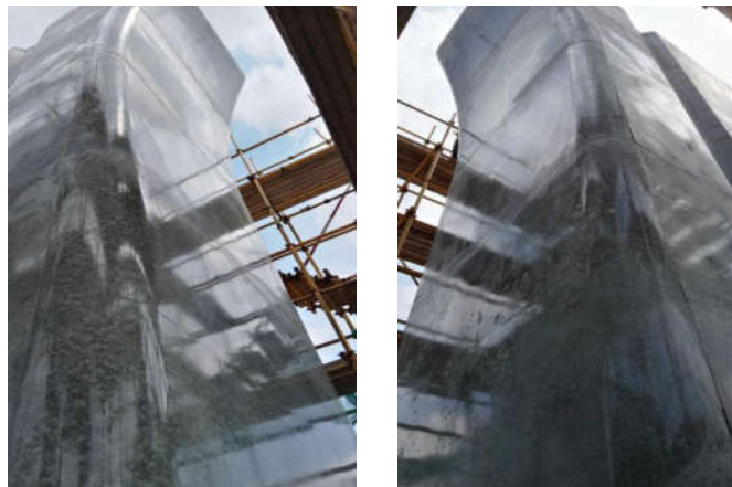
墩柱镜面混凝土施工效果
