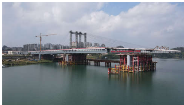
图5 130m跨度永临结合顶推支墩实施图
